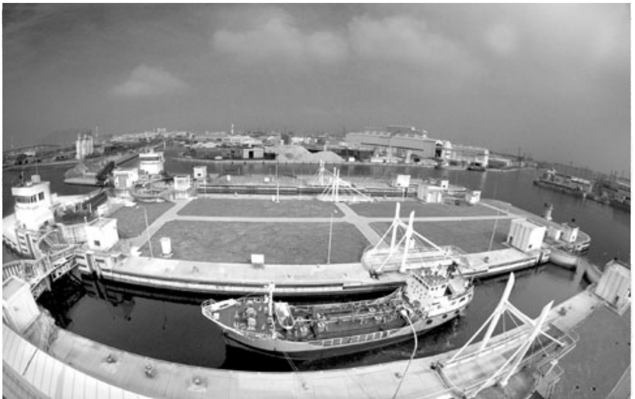
1日平均30隻が通過する尼崎閘門。左が海側、右が運河側で、船がある真ん中の閘室で水位を調整する。両開き式の閘門はレオナルド・ダ・ビンチが考案したと言われている
